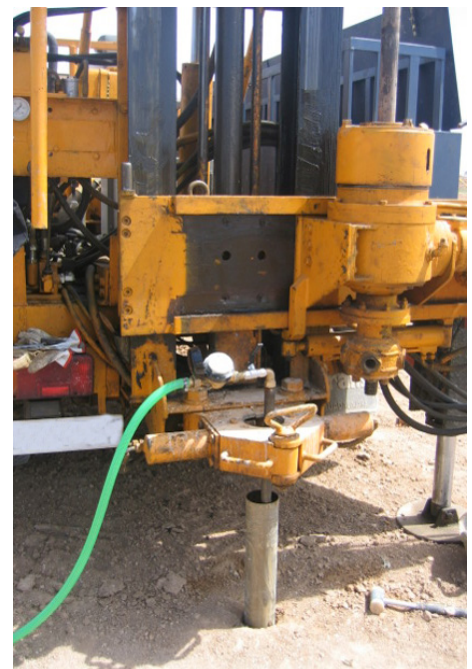
Medida de permeabilidad por inyección de agua (Cortesía de TYPESA)
